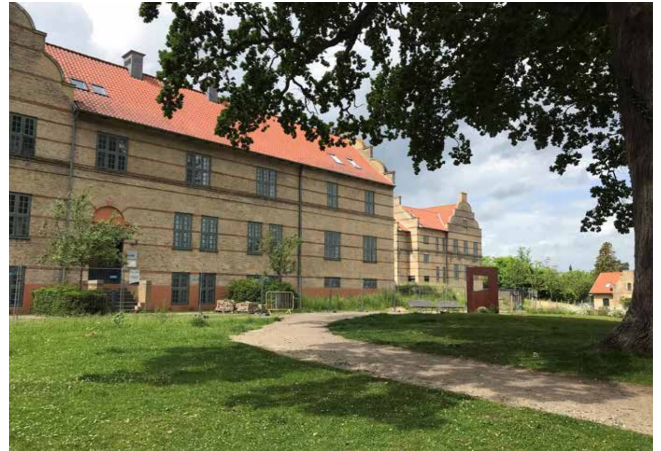
De gamle hospitalsbygninger er tegnet af Bindesbøll. De er fredede og bliver renoveret og ombygget til boliger.
